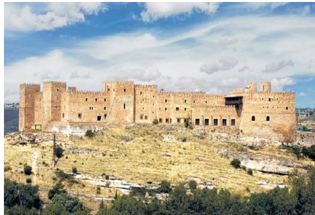
der Parador von Siguenza, unsere Unterkunft für die ersten beiden Nächte, ist ein mittelalterlicher Burgpalast, heute stilvolles 4-Sterne Hotel
