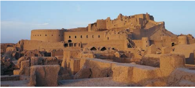
Wiederaufbau der Lehmzidatelle von Bam
