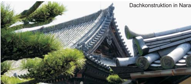
Dachkonstruktion in Nara
