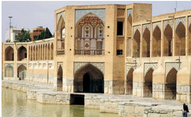
Isfahan - Pol-e Chādschu, Brücke von 1650 über den Zayandeh Rud
