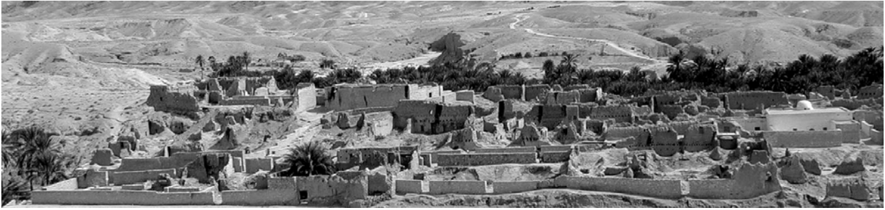
Die aus Lehmziegeln errichtete Altstadt der Gebirgsoase Tamerza wurde Ende der 1960er Jahre bei einem Starkregenereignis zerstört.
