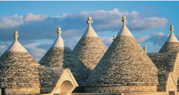
traditionell im Trockenbau errichtete Trulli in Alberobello
