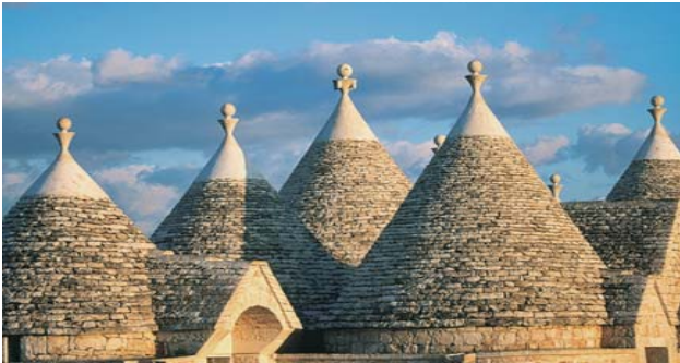
traditionell im Trockenbau errichtete Trulli in Alberobello
