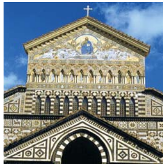
Amalfi, Detail Domfassade
