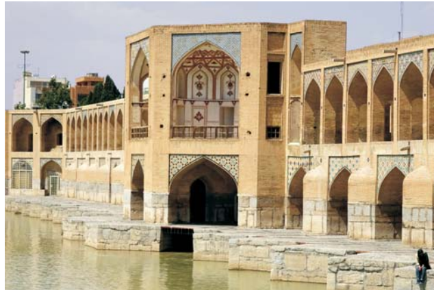
Isfahan - Pol-e Chādschu, Brücke von 1650 über den Zayandeh Rud
